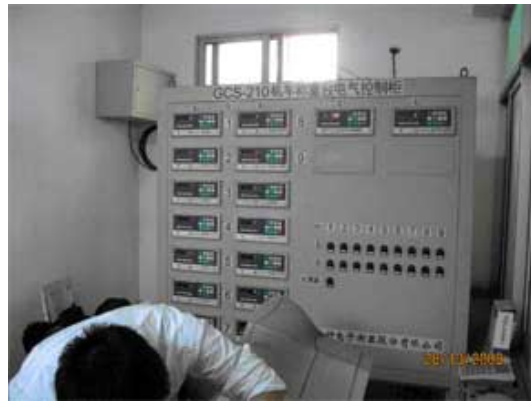
图3 控制室中的仪表集控柜
