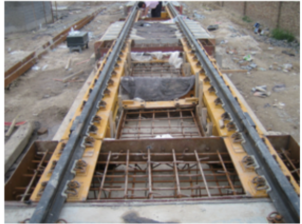
图 6 两梁断轨衡的现场施工照片
