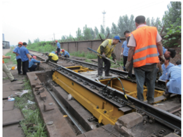
图 10 有底架断轨衡安装照片
