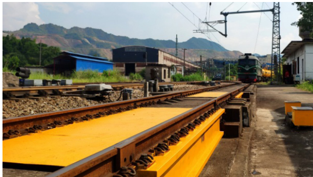
图1 轨道衡室外实景图
