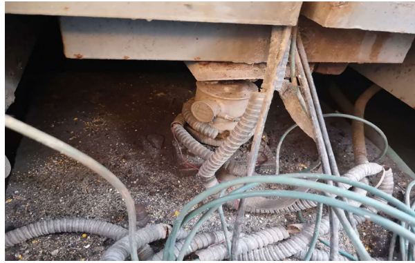
图 1.2 汽车衡使用过程中旋转缠线现象
