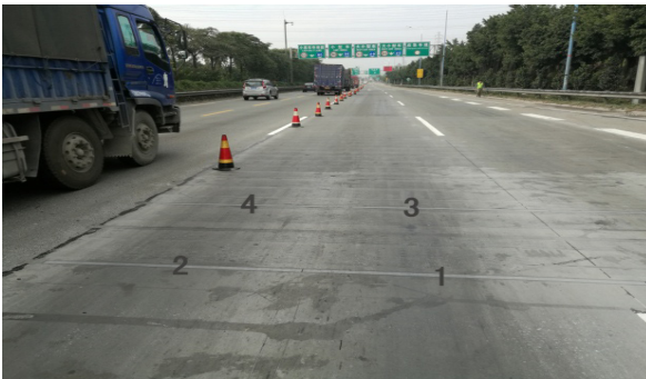
图3 平板模块式动态公路车辆自动衡器
